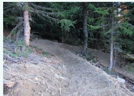
La future piste bleue de VTT. Le terrassement de deux pistes de VTT a été réalisé à partir du sommet du télésiège de Vinouva pour descendre à la station.
